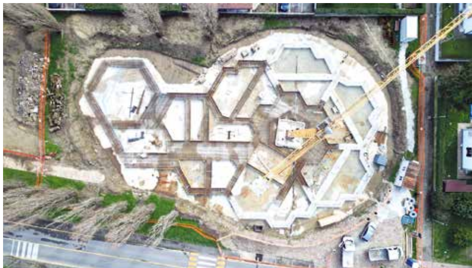
Scuola Materna in costruzione
