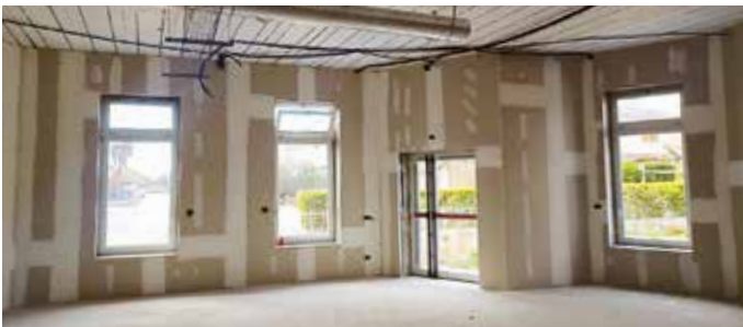
Cantiere veduta interna Scuola Materna
