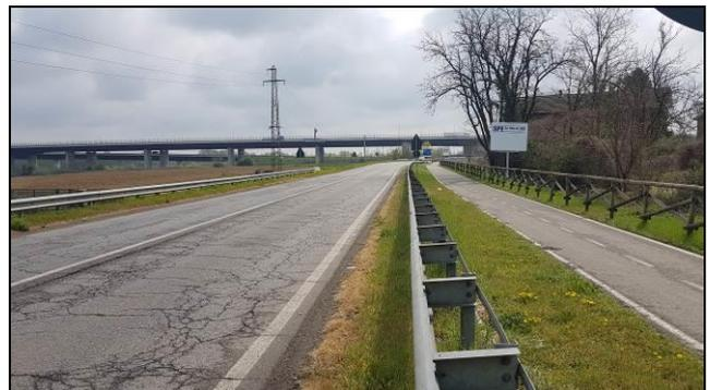
La strada esistente ha una carreggiata in conglomerato bituminoso di circa 7,50 m di larghezza, a due corsie di 3,50 m e banchine in terra e barriere metalliche di sicurezza che la separano dalla pista ciclabile.
